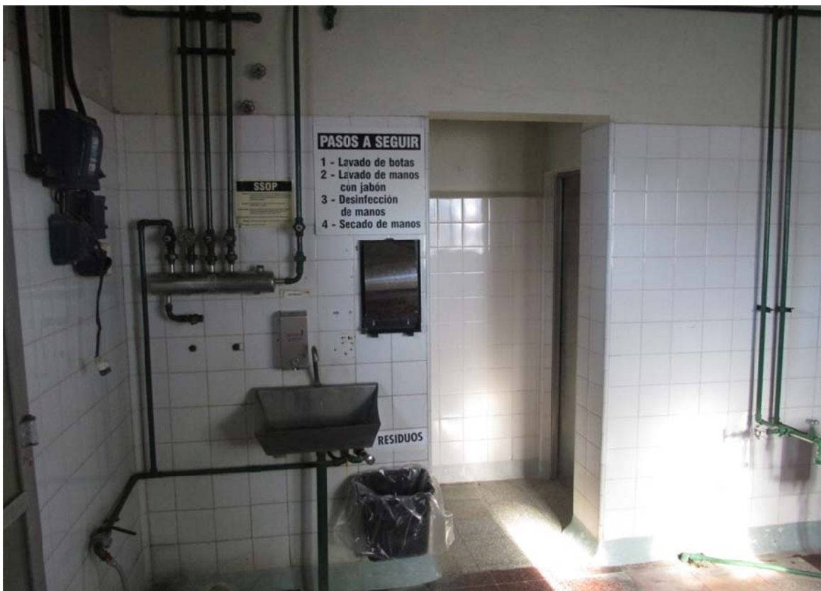
Foto 18. Ingreso a sala de necropsia con el correspondiente filtro sanitario.
